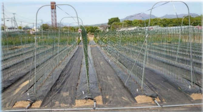
支柱、灌水設備等を設置した状況
